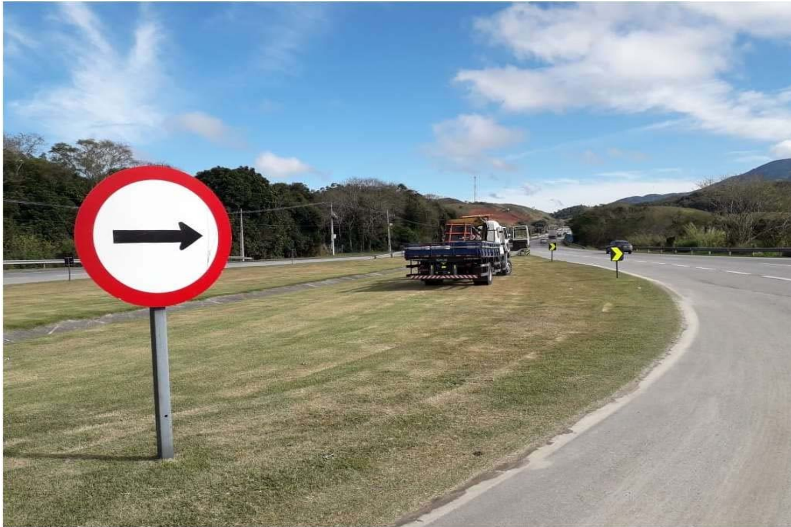
FOTO 05 - Reparo de Placa - Km 4+200 Sul F3
