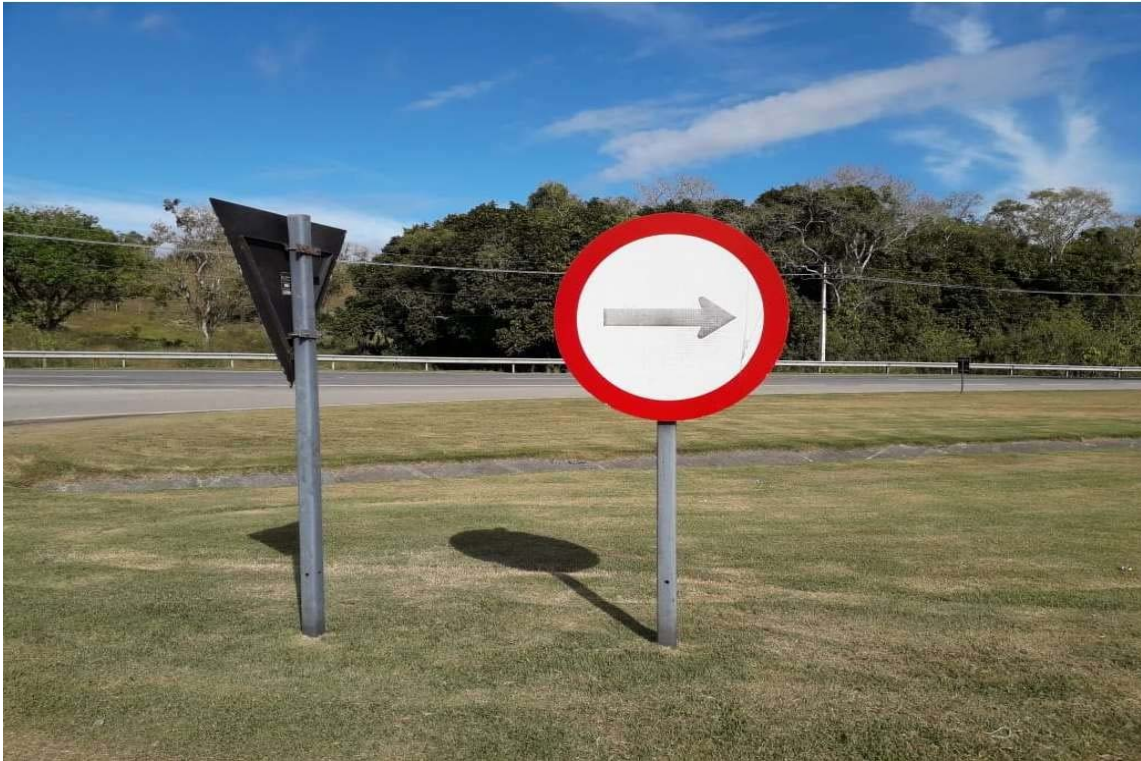
FOTO 03 - Reparo de Placa - Km 4+200 Sul F1
