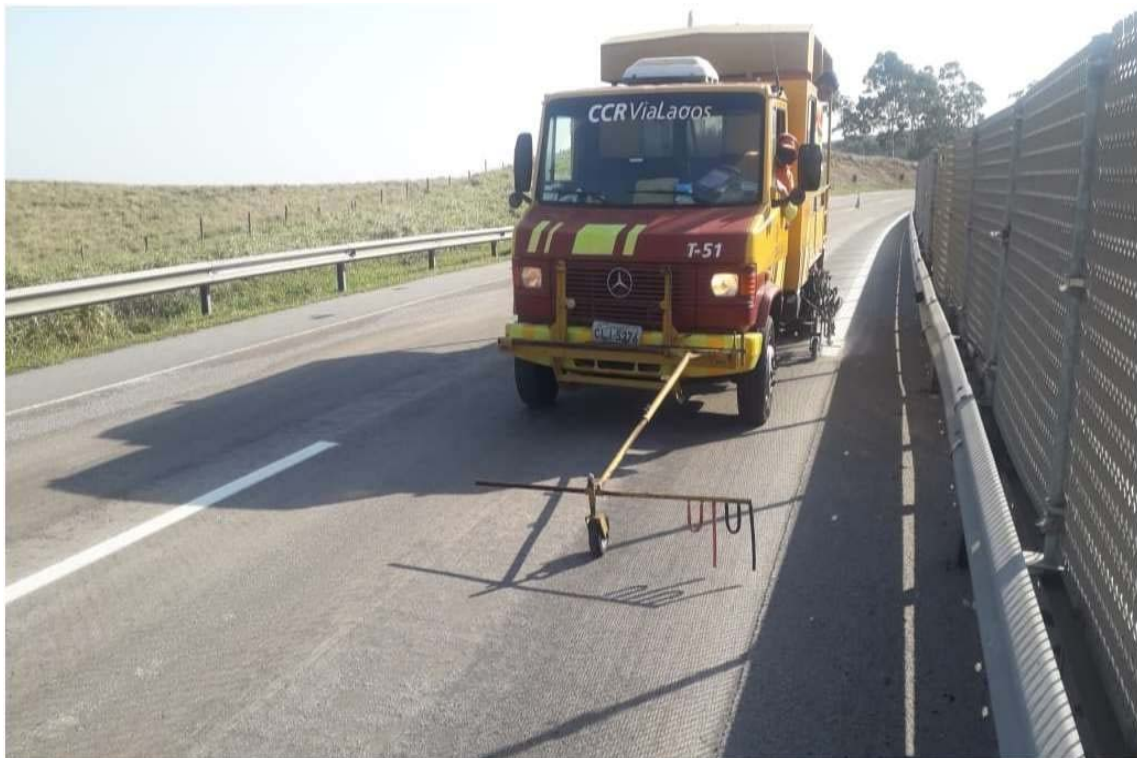
FOTO 02 - Pintura de Faixas - Km 45+000 Norte F1
