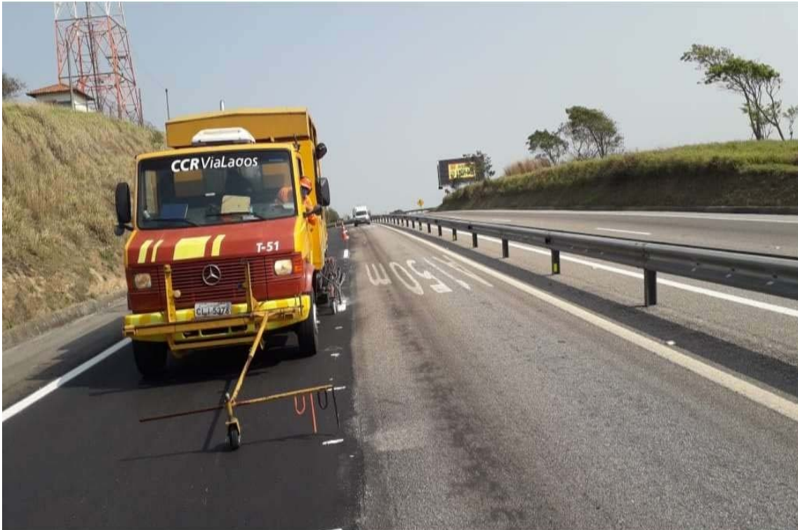
FOTO 01 - Pintura de Faixas - Km 44+000 Norte F1
