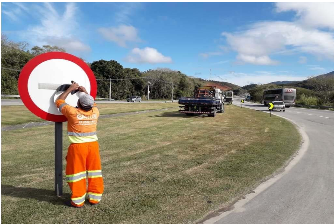
FOTO 04 - Reparo de Placa - Km 4+200 Sul F2
