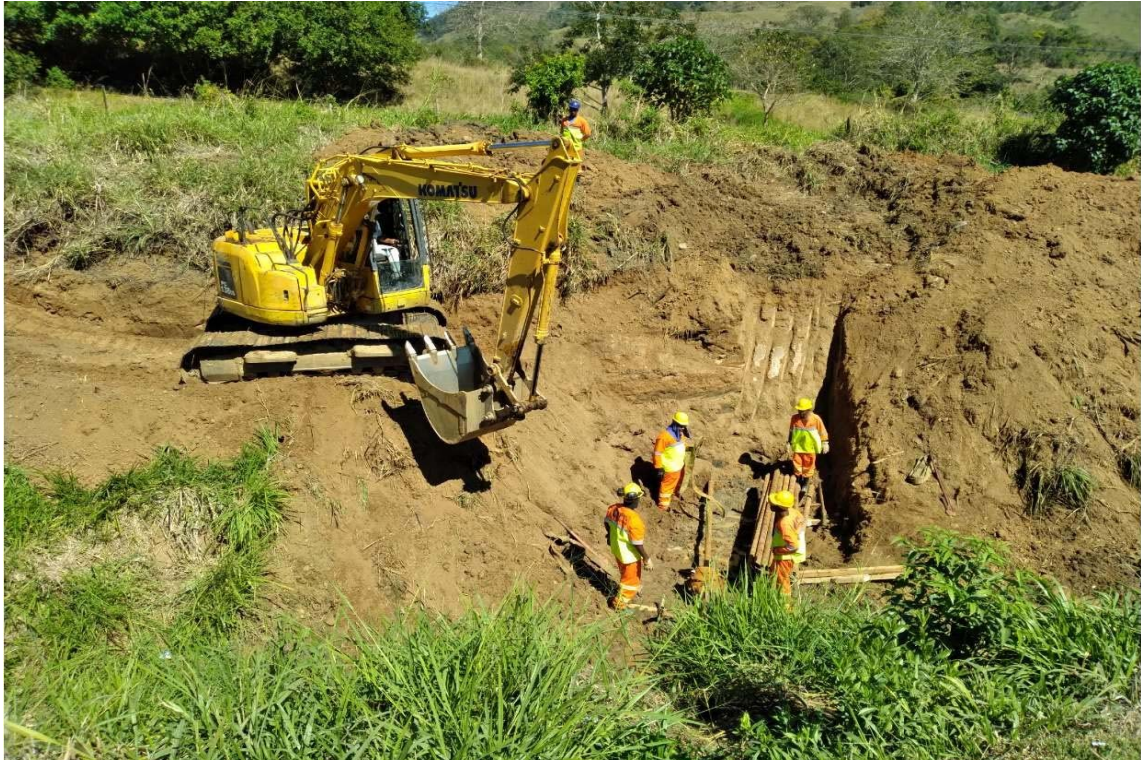
FOTO 08 - Ampliação Bueiro - Km 9+535 F1
