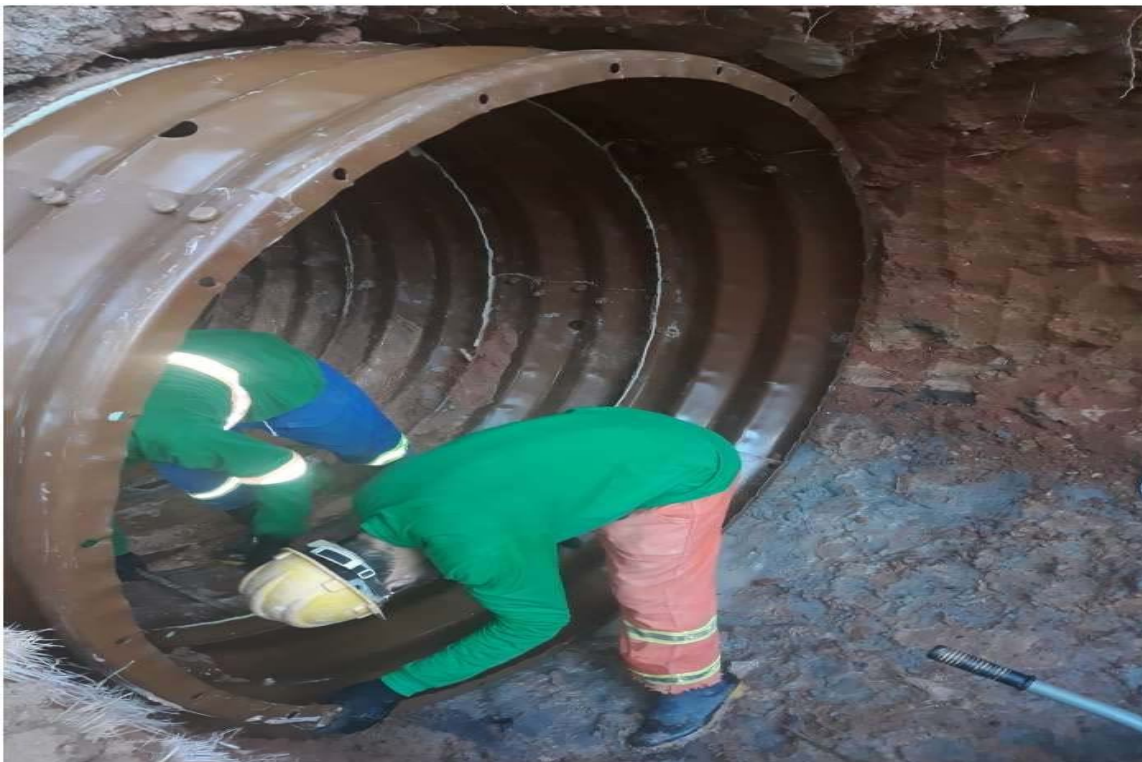
FOTO 11 - Ampliação Bueiro - Km 29+320 F2
