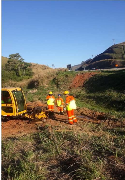
FOTO 09- Ampliação Bueiro - Km 9+535 F2
