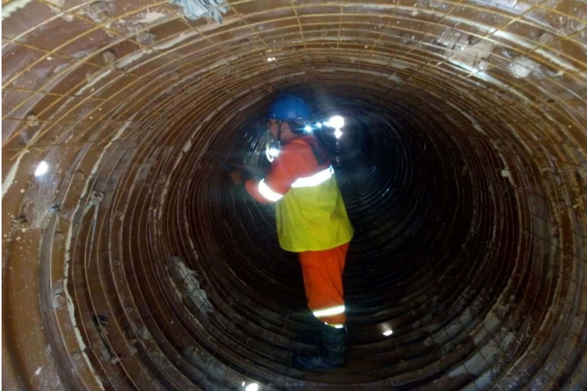
FOTO 12 - Ampliação Bueiro - Km 29+320 F3
