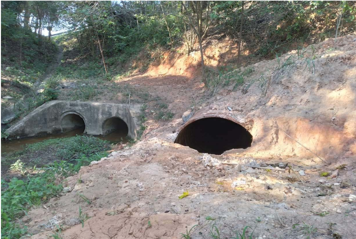
FOTO 10- Ampliação Bueiro - Km 29+320 F1
